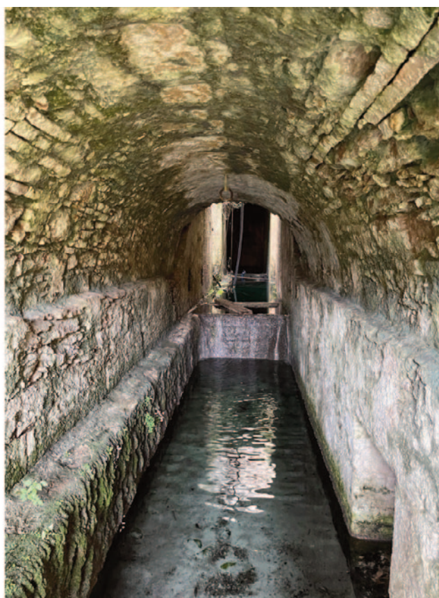
Fig. 52. Messaga, sifone e cunicolo dell'acquedotto.
